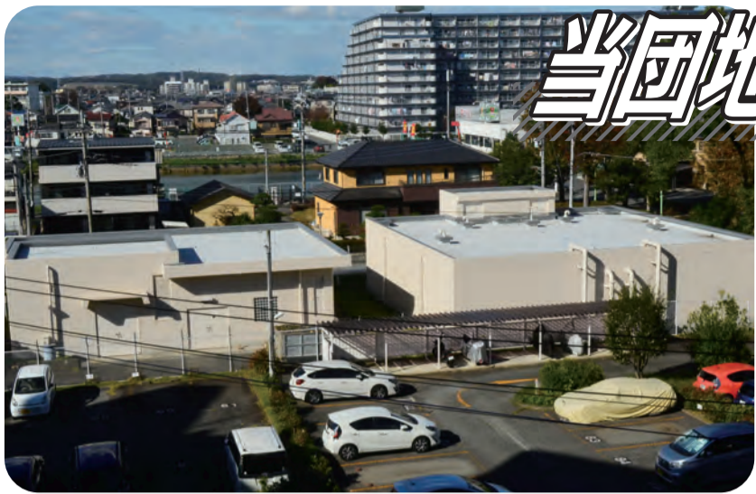
ポンプ室(左)と、廃止し防火水槽に転用される受水槽
