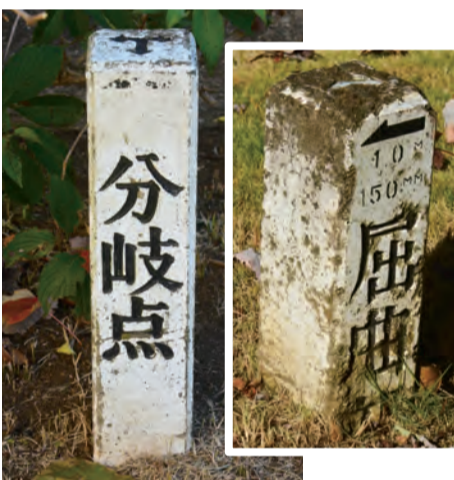
撤去し残土で埋め戻す給水管標示杭
