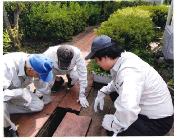
側溝のフタの点検作業
