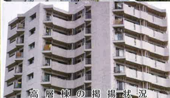
高層棟の掲揚状況
