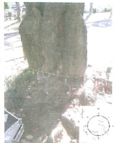
測定状況写真
