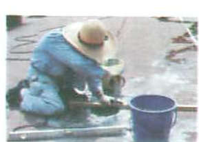
コート下地整備
