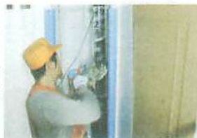
メーターボックス内配管工事
