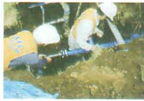
埋設給水管切替工事
