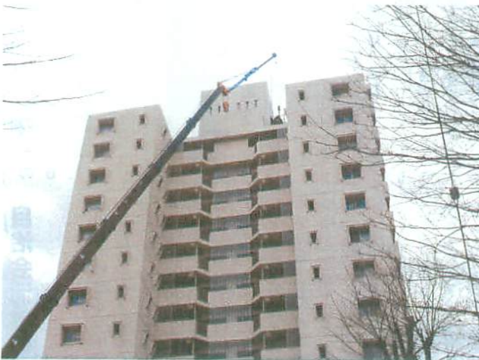
高層棟の資材揚げ作業
