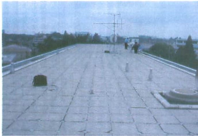
6号棟屋上防水層外観調査
