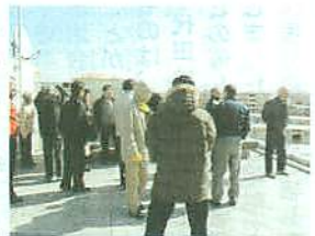
屋上防水工事見学
