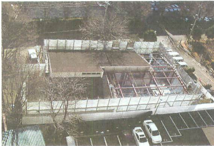
組合員の皆さんの期待を背に着々と進む改築工事
