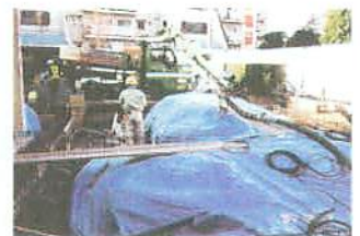
基礎コンクリート打設作業
