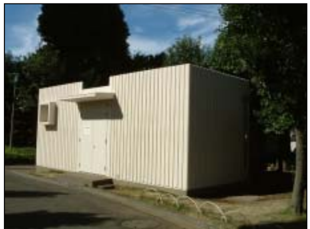
工事後の電気室
