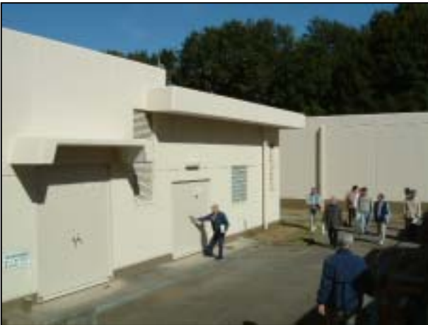
工事後のポンプ室と受水槽
