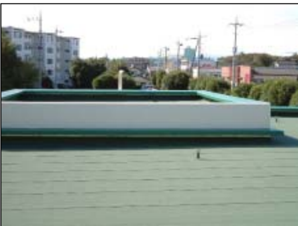
新設されたポンプ室屋上防水
