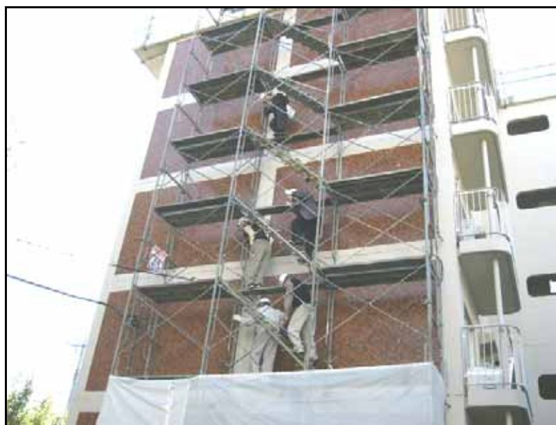
施工検査風景(仮設足場で昇り降りする修繕委員会メンバー)
