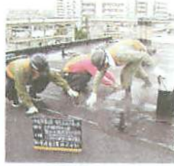
屋上防水工事
