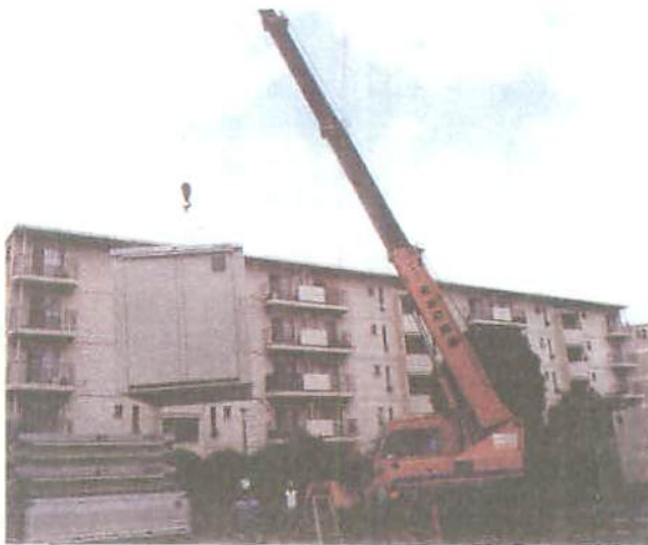
クレーン車による屋上資材上げ
